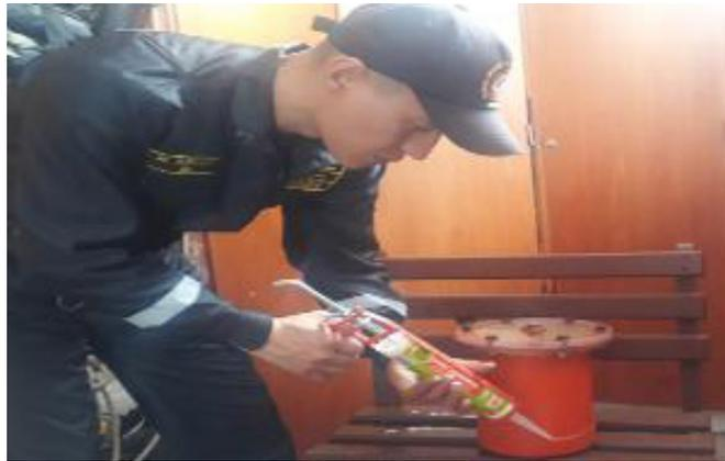
**Figura 15. Impermeabilización tapa inferior**
