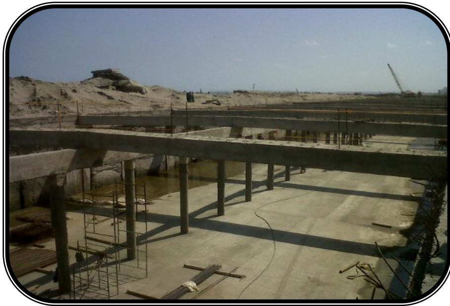
Figura 3. Estado de obras del Proyecto. Fuente: Autor
