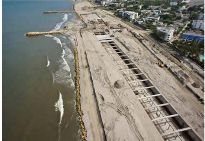
**Figura 1.** Vista aérea del Túnel, ensanchamiento litoral y espolones de seguridad. Recuperada de [http://www.consorcioviaalmar.co/av\\_crespo.html](http://www.consorcioviaalmar.co/av_crespo.html)
